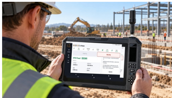
施工现场记录
