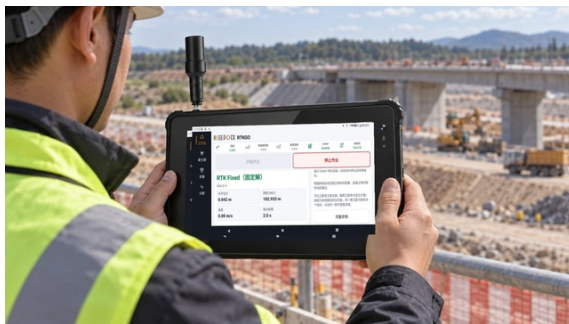
工程现场检查
